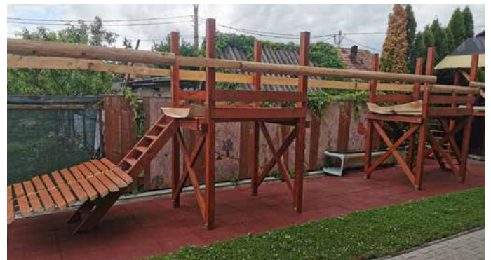
Sandor baut eifrig am neuen Spielplatz, damit er bis zur Einweihungsfeier im Oktober fertig wird.
